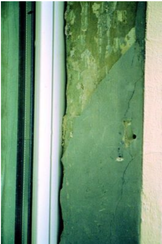
Abbildung 13: Mangelhafte Fugenausbildung
