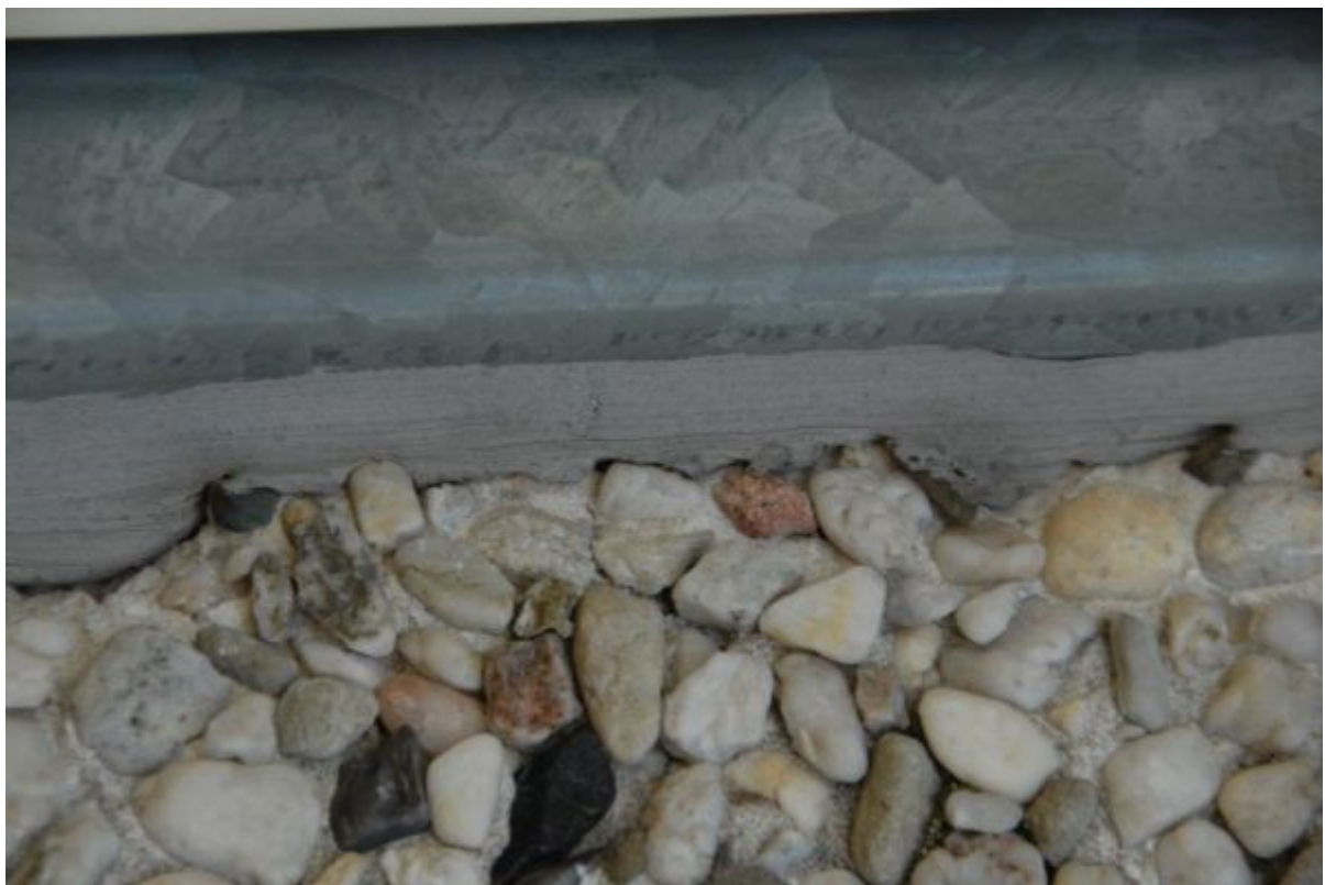
Abbildung 9: Verfugung ohne Abfasung der Haftflächen führt zu Haftverlust
