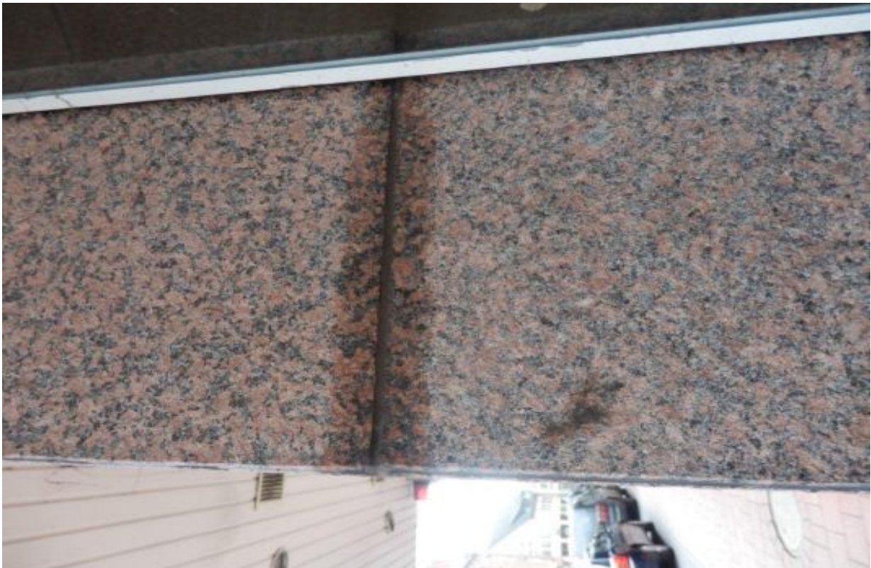
Abbildung 5: Randzonenverschmutzung des Natursteins durch ungeeigneten Dichtstoff
