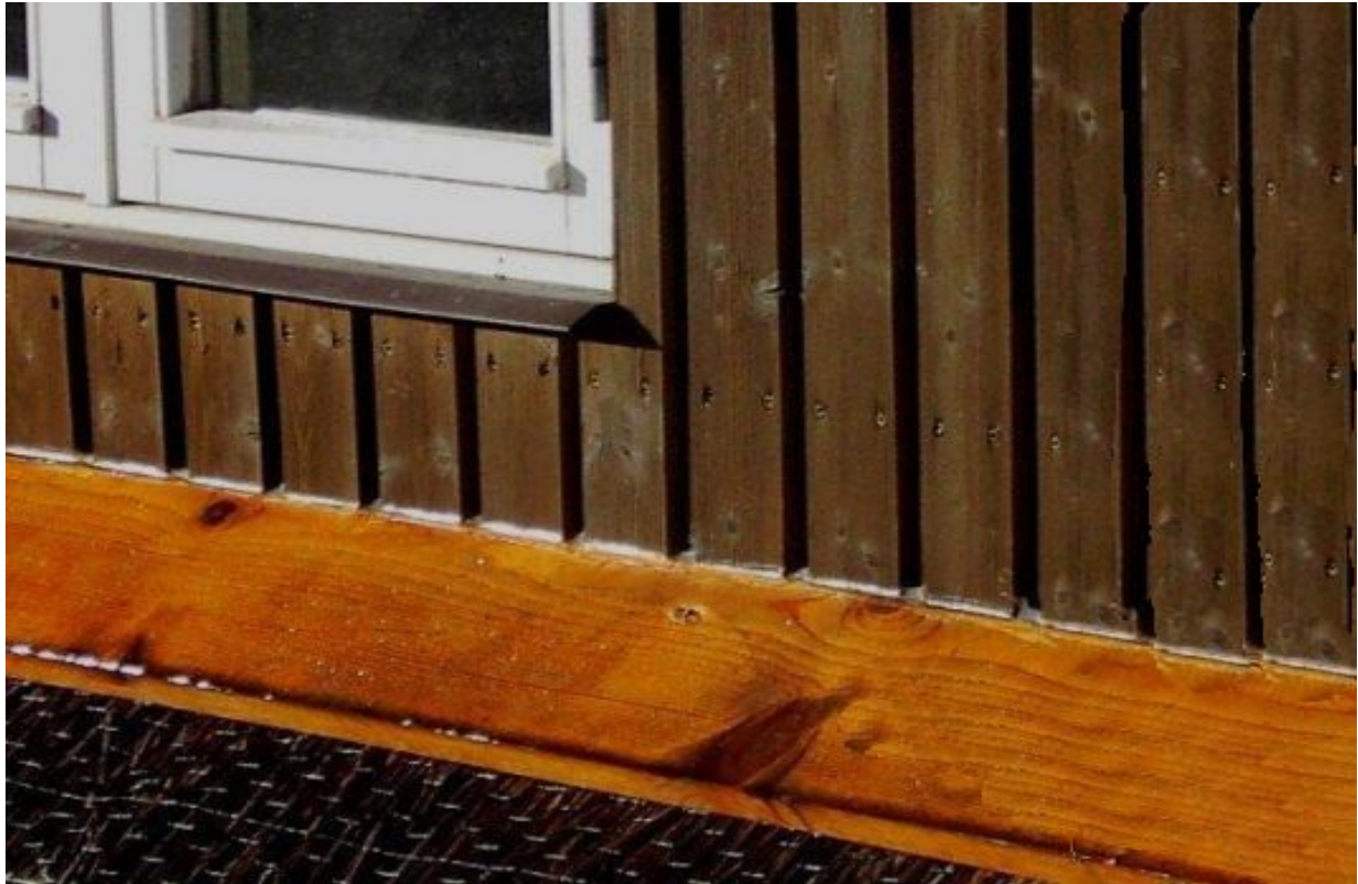
Abbildung 6: Verfugung von nicht maßhaltigen Bauteilen
