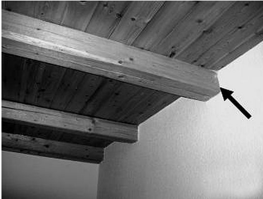
Abbildung 39: Deckenbalkendurchführung in die Wand
